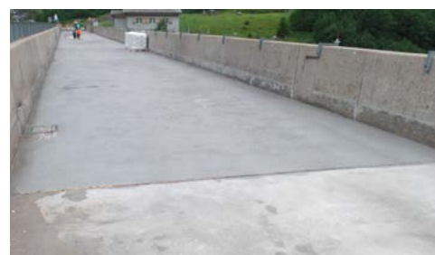
ÜBERBETON FAHRBAHNPLATTE
