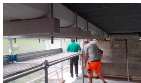
EXTERNE QUERKRAFTVERSTÄRKUNG
