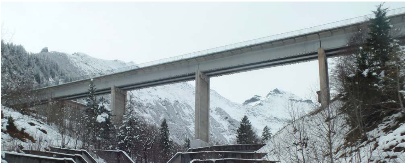
WALENBRÜCKE MIT SPERRENTEPPICH WICHLENBACH (8767 ELM/GL)
