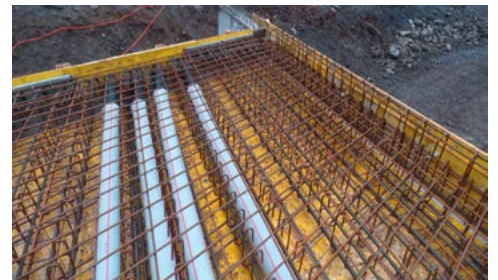
BEWEHRUNG BRÜCKENPLATTE
