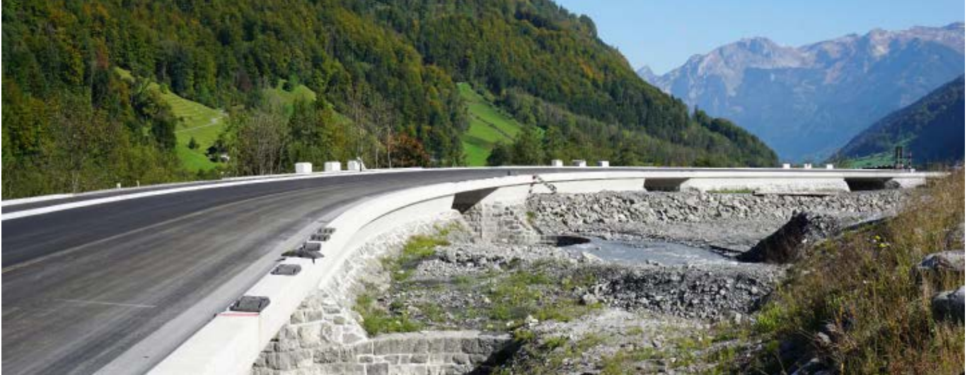
DURNAGELBRÜCKEN 1 BIS 4, SICHT IN RICHTUNG RÜTI
